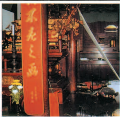
崩れ落ちた本堂内陣
