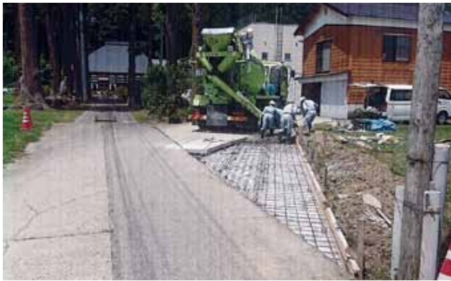
入口拡張工事
